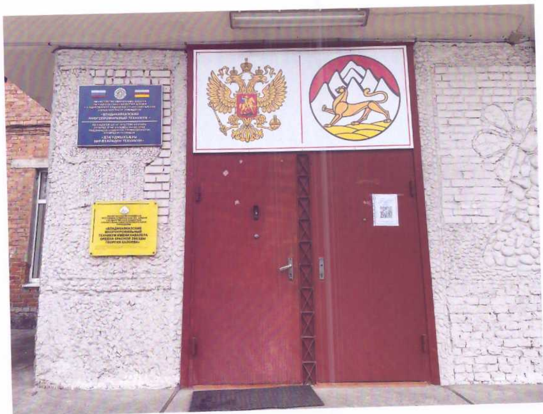
Фото № 6 Дверь (входная)
