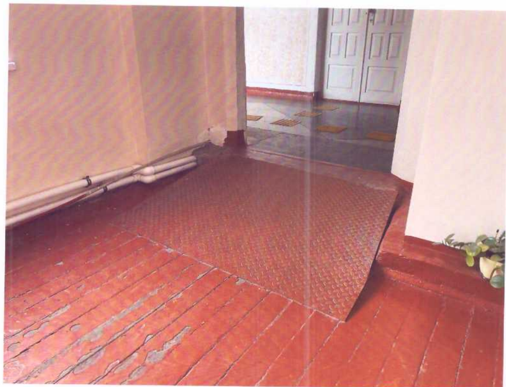
Фото № 10. Пандус (внутри здания)
