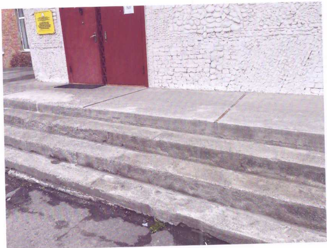
Фото № 2 Лестница (наружная)
