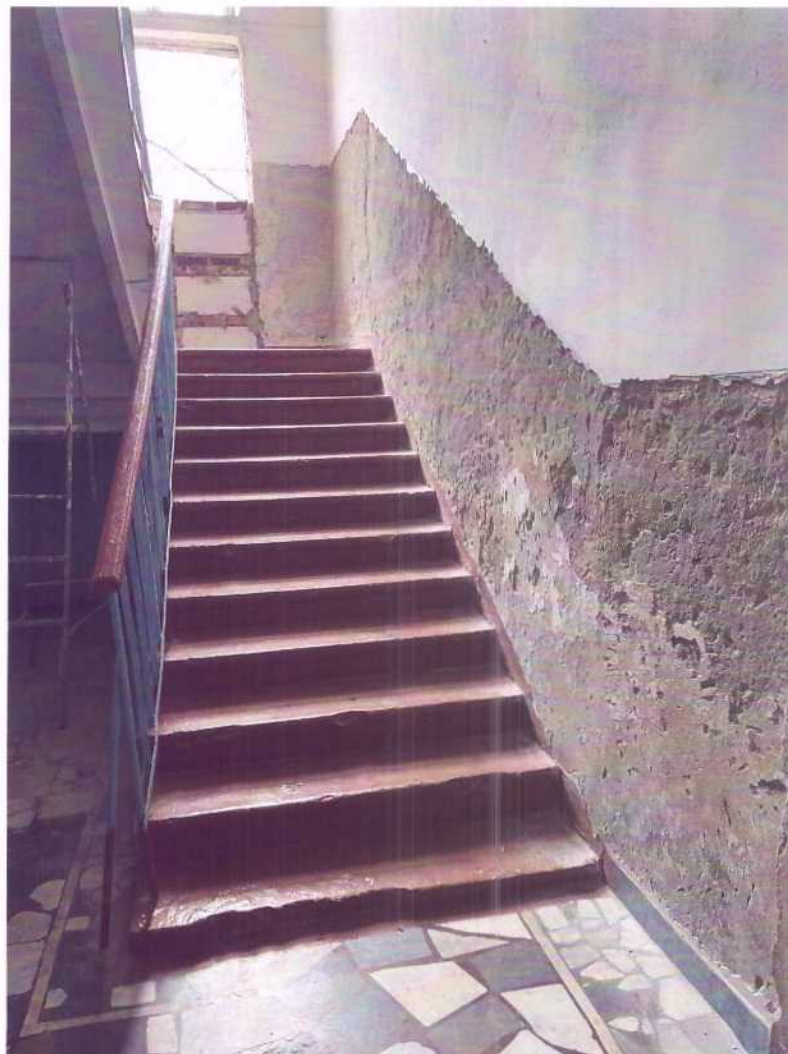
Фото № 6. Лестница учебного корпуса № 2
