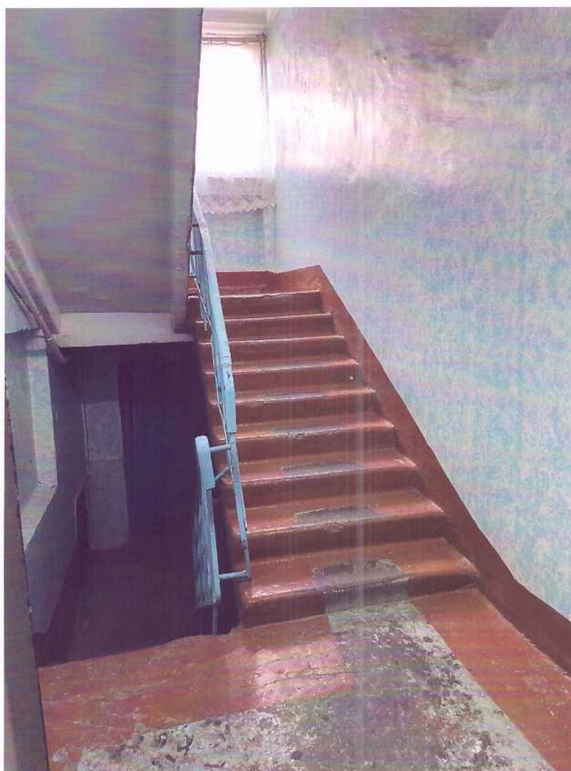
Фото № 6. Лестница корпуса № 3. Общежитие.
